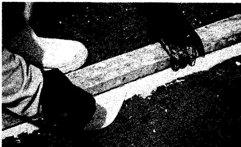
Depois de colocar as juntas plásticas (ou de latão) nas áreas marcadas, fixe-as com uma camada fina de argamassa de cimento branco e areia (3: 1). Use uma régua de alumínio para auxiliar na tarefa e manter o alinhamento das juntas.
