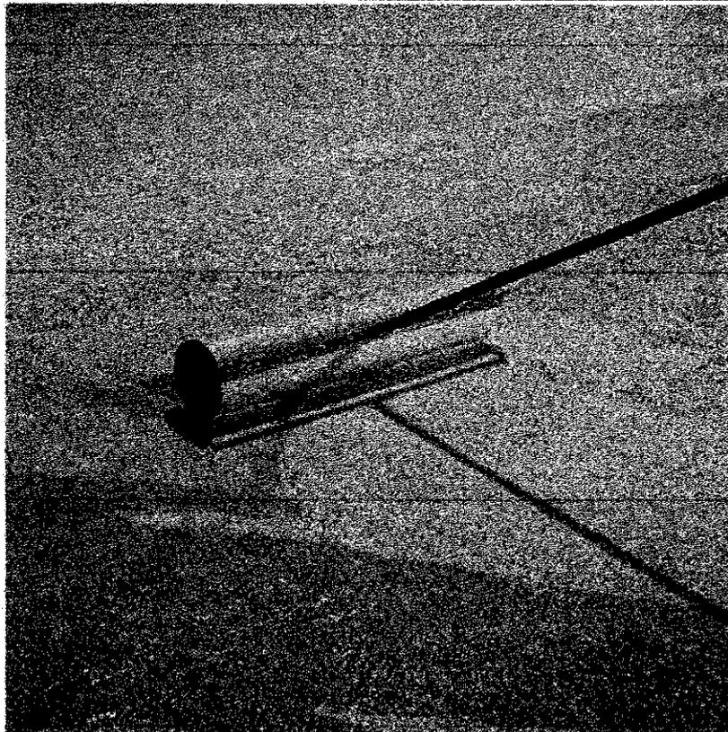
Em seguida, use um rolete (que pode ser feito com cano de PVC preenchido com concreto) para compactar os agregados na massa.
