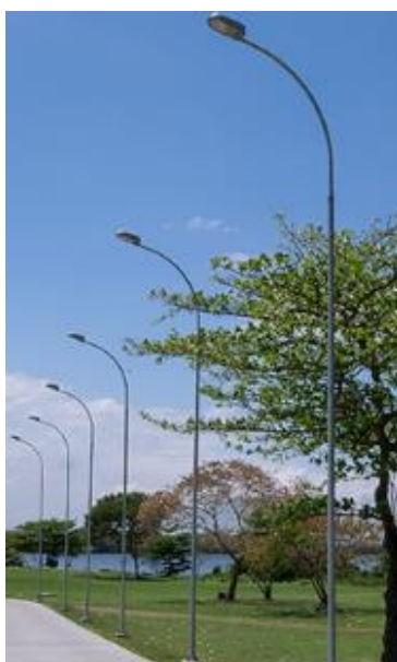
Figura 8 – Representação disposição luminária em poste curvo simples 6m
