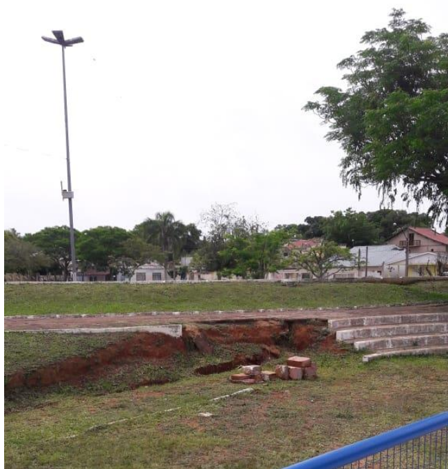
Figura 2 – Reforma de calçada com aplicação de meio fio e muro de contenção
